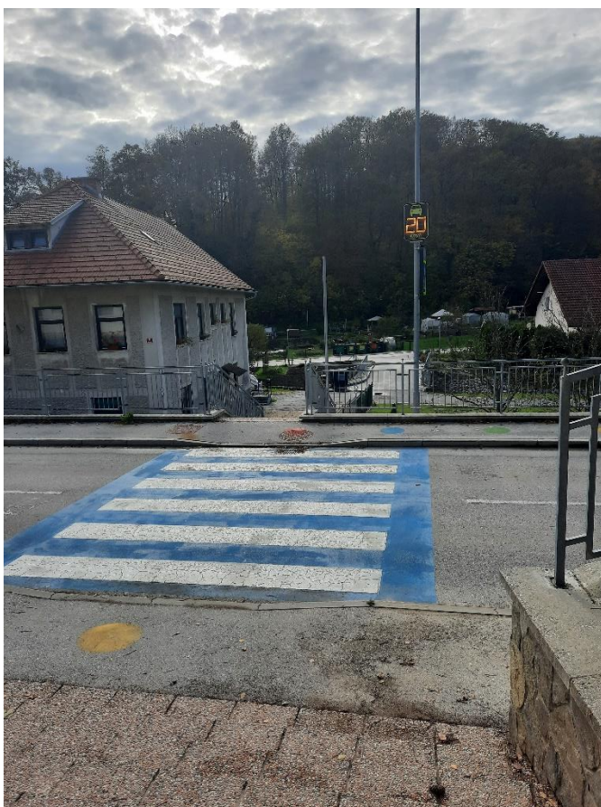
Slika 4: Pravilne in dobro vidne talne označbe na vozišču pred šolo in z barvnimi pikami označena najvarnejša pešpot ter svetlobno opozorilo z meritvijo hitrosti vožnje.
